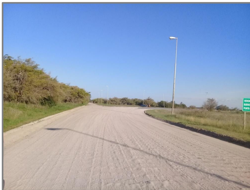
Figura N°32. Vista del distribuidor de tránsito en la intersección con el camino de acceso a la ciudad de Verónica y el alumbrado público para señalar.
