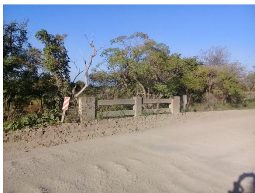
Figura N°38: a) Vista de la Alcantarilla 2
