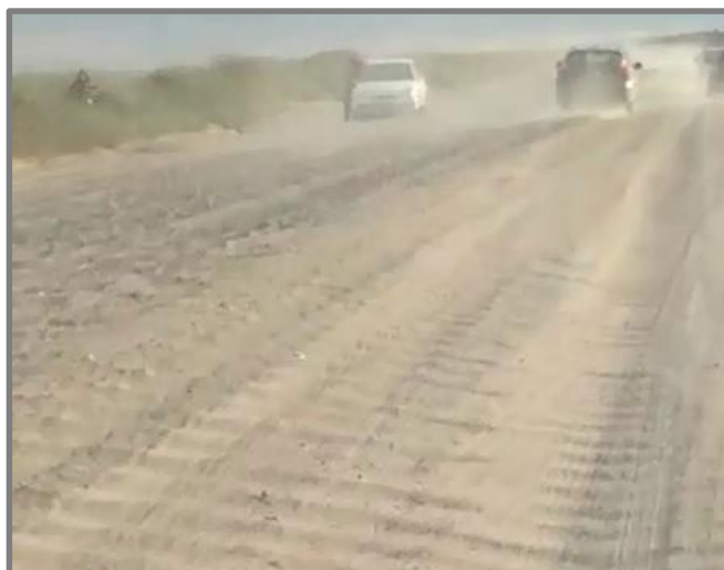
Figura N°30.- Vista del material particulado circundante durante el desplazamiento de vehículos
